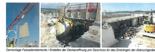
Demontage Fassadenelemente / Erstellen der Deckenöffnung pro Geschoss für das Einbringen der Abbruchgeräte
